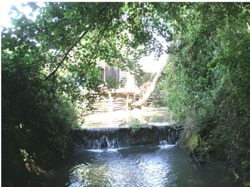
Exemple d'un obstacle à l'écoulement sur le cours de l'Orne. Il influe, à la fois sur la capacité d'auto-épuration mais aussi sur la libre circulation des espèces piscicoles et des sédiments.
