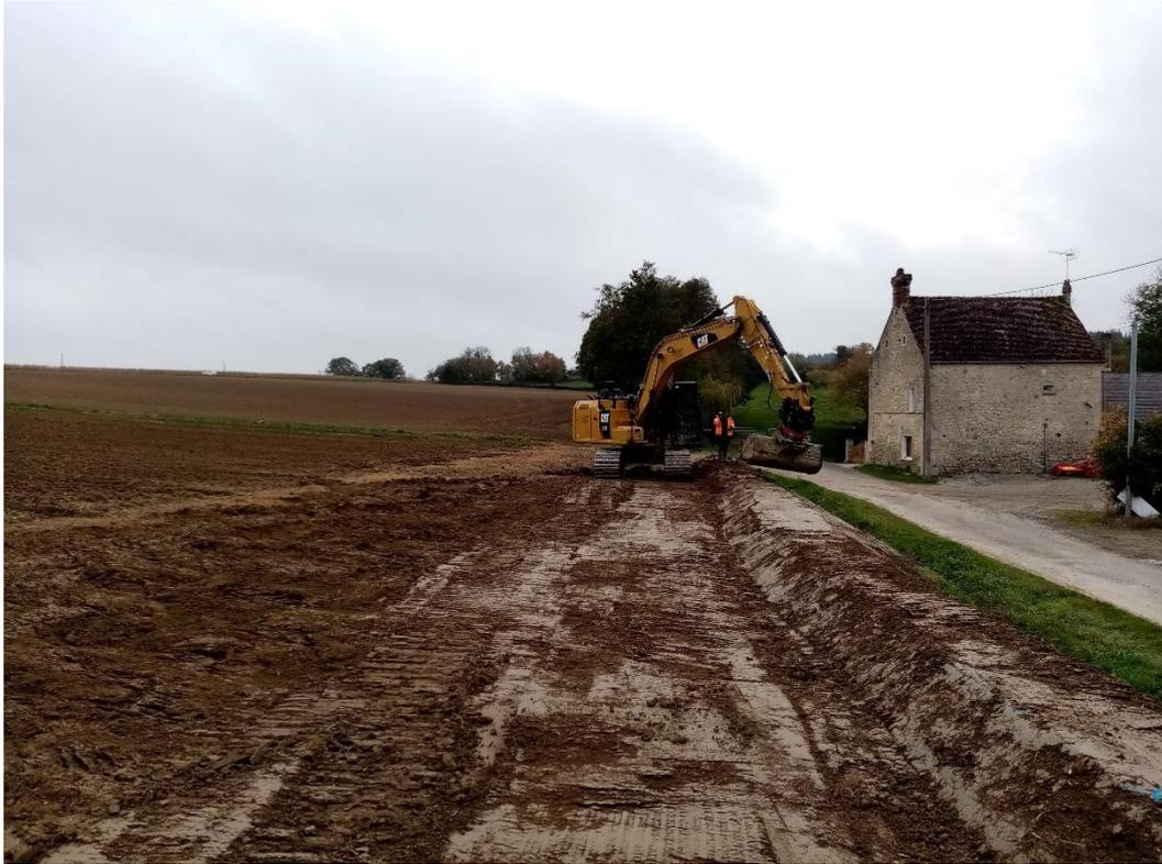
*Photo d'un talus en cours de réalisation*
